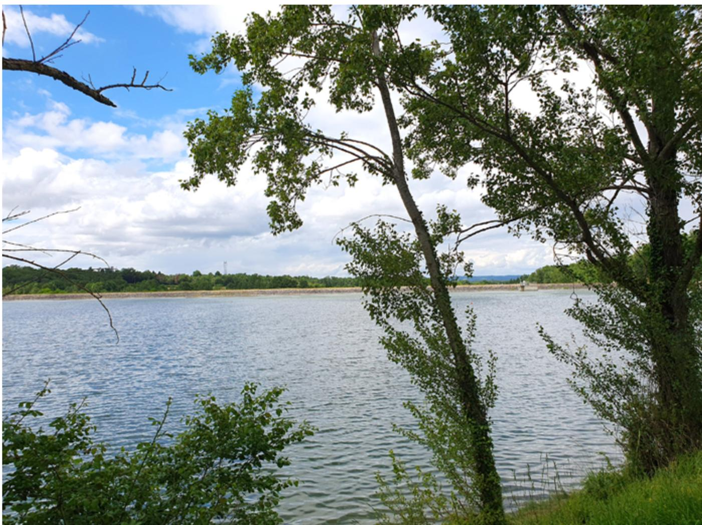
**Retenue d'eau et irrigation** : Ce plan d'eau de 64 hectares a été créé en 1991 (achevé en 1992) à l'initiative du Conseil général de Tarn-et-Garonne grâce à l'édification d'un barrage en terre de 175 mètres de long sur le ruisseau du Tordre (affluent de l'Aveyron), générant une retenue d'eau de 3,2 millions de m<sup>3</sup> principalement destinée à l'irrigation.
